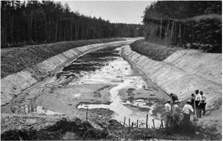
Bau des Pfinzentlastungskanal durch den Hardtwald
